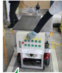
自作した分電盤を使った操作スイッチ
